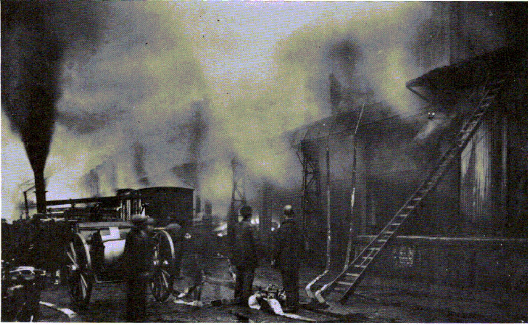
De stoompompen in volle activiteit bij de blussingswerken aan de Voorhaven in 1919.
